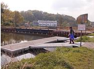
Steg vor Schleuse Stiepel/Blankenstein 7.5.2017
