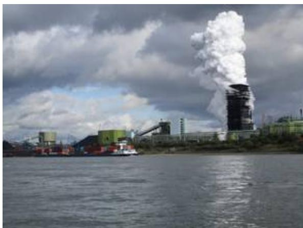
Alle paar Minuten wird der glühende Koks gelöscht.
