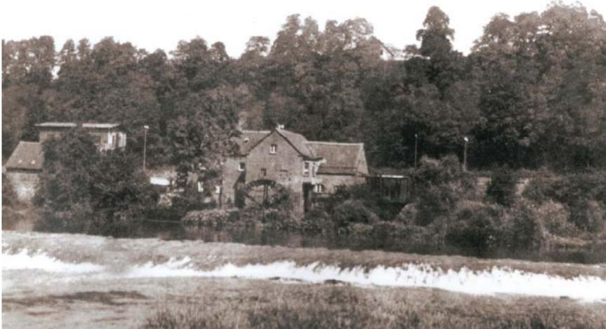
Wegen der Schiffbarmachung der Ruhr auf Geheiß Friedrichs des Großen ließ der Freiherr von Vittinghoff Schell im Jahr 1774 unterhalb der Mühle ein Wehr und eine Schleuse bauen. An der Mühlenschleuse entstand zudem ein Rasthaus aus Stein, da die Schiffer nachts auf der Ruhr nicht fahren durften.
