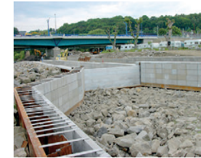
Befestigungselemente der Ruhrsandsteinverblendung (Bootsgasse)
